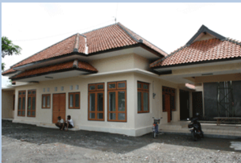
Rumah Rehabilitasi Graha Yoga Pertiwi
